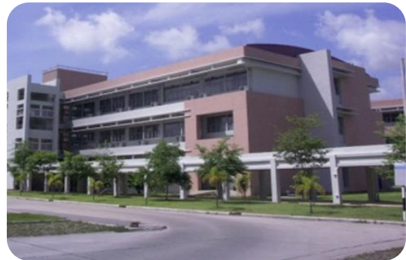
อาคารปฏิบัติการพื้นฐานทางทันตกรรม (NSU 02)
